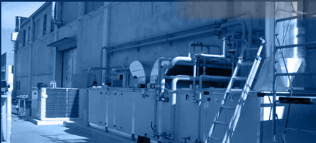
vista globale esterna impianto in fase di realizzo /external global view of the plant under construction
