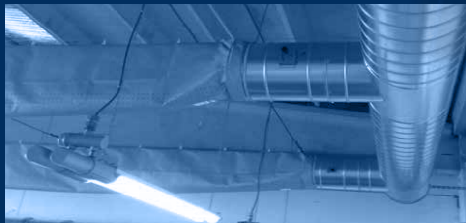
vista distribuzioni jet-in classe 0 e serranda di regolazione\esclusione / jet-in distributions class 0 , and regulation\exclusion damper view
