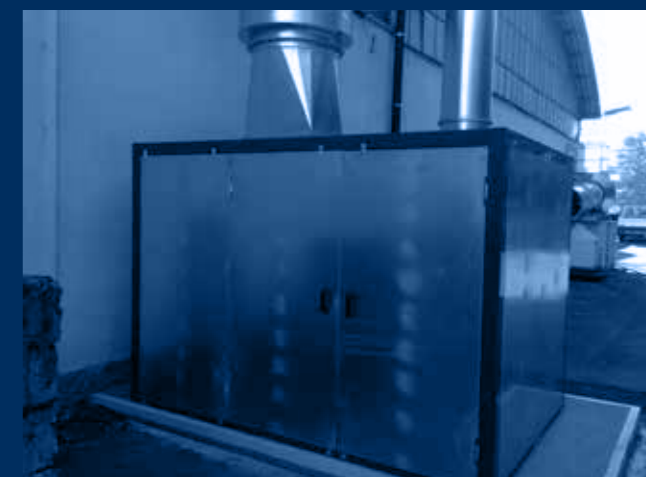
vista box afono ventilatore /soundproofed box view
