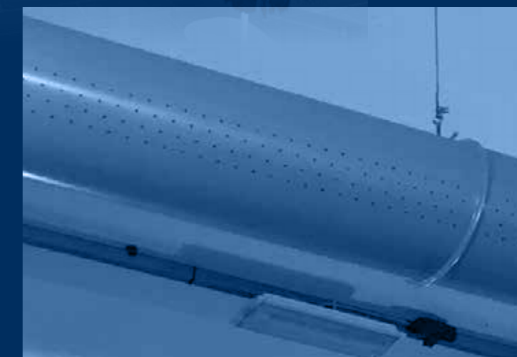
vista particolare microforatura / microdrilling particular view
