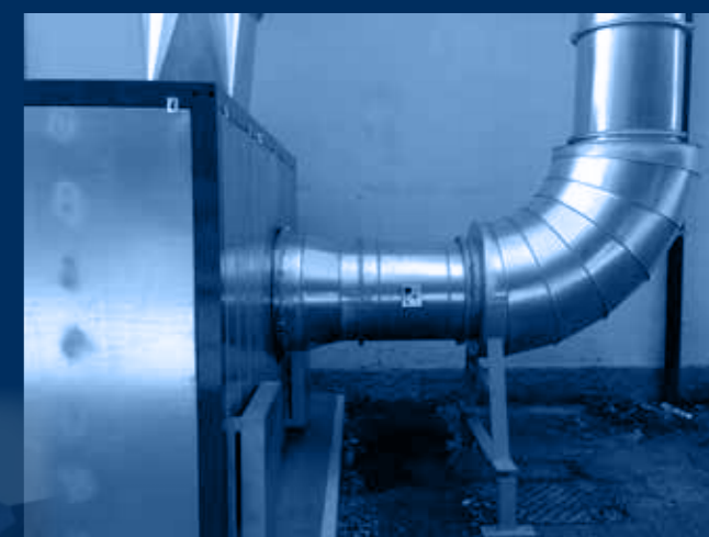
vista silenziatore circolare / circular silencer view
