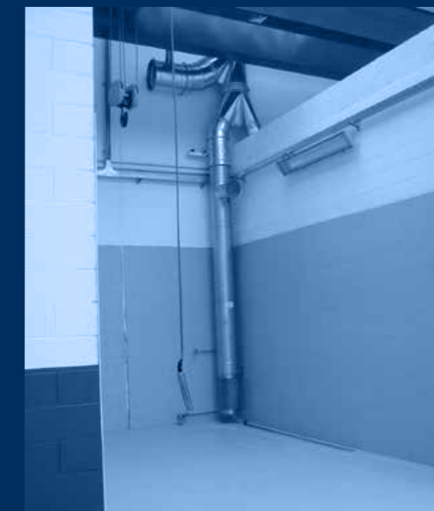
vista distribuzioni interne / internal distributions view
