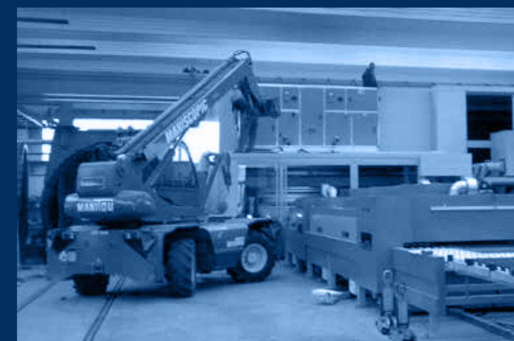
fasi di montaggio UTA deumidificazione spinta /assembly stages of UTA pushed dehumidification
