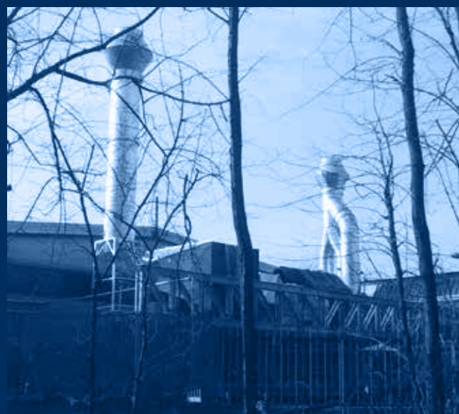
vista insieme depuratore in fase di ultimazione / post-combustion near completion view
