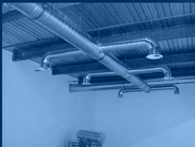
distribuzione a vista con diffusori alta induzione / view distribution with high induction diffusers
