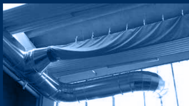
vista interna distribuzione immissione e canale jet-in / internal view of air distributions with jet-in duct
