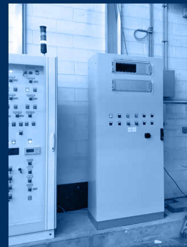
vista quadri rilevazione gas / gas detection panel view
