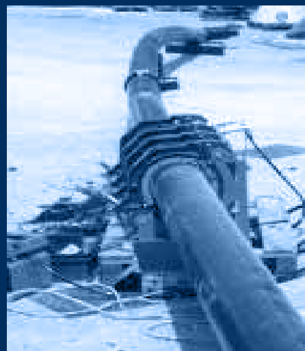
vista posizionamento tubazioni / installation pipes view
