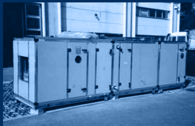
fase di installazione centrale trattamento aria / air handling unit installation phase
