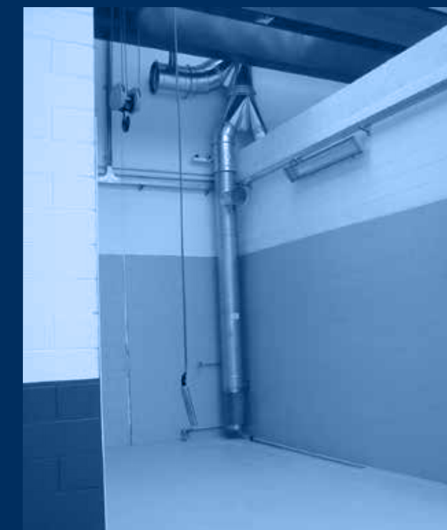
vista distribuzioni interne / internal distributions view
