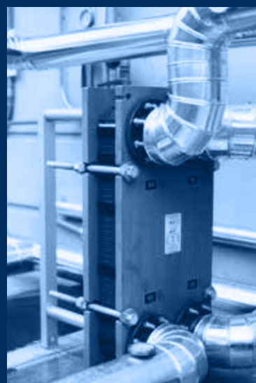
scambiatore h2O/water exchanger
