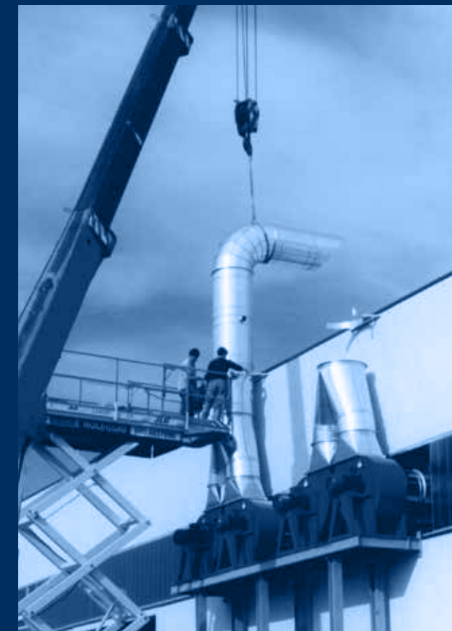
vista impianto esterno in fase di montaggio /external plant in phase of assemblage view
