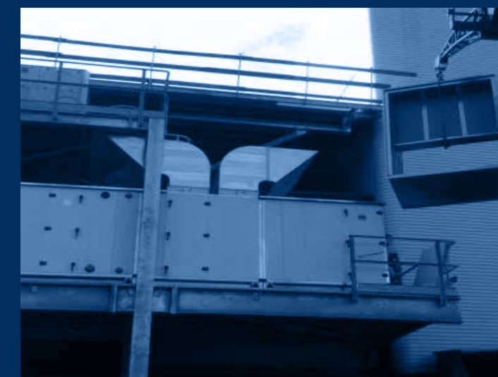
fasi di montaggio UTA /assembly stages of AHU
