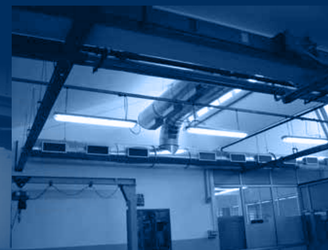
vista interna al reparto con particolare del canale di mandata aria / inside view of the plant with distinctive of the delivery air duct
