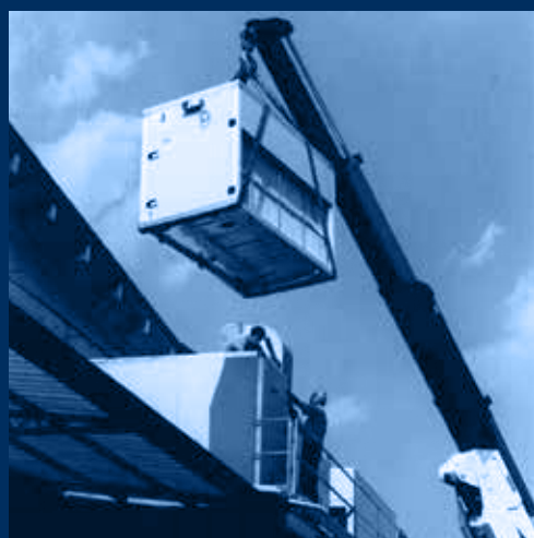
fase di montaggio recuperatore /phase of heat recover assembly
