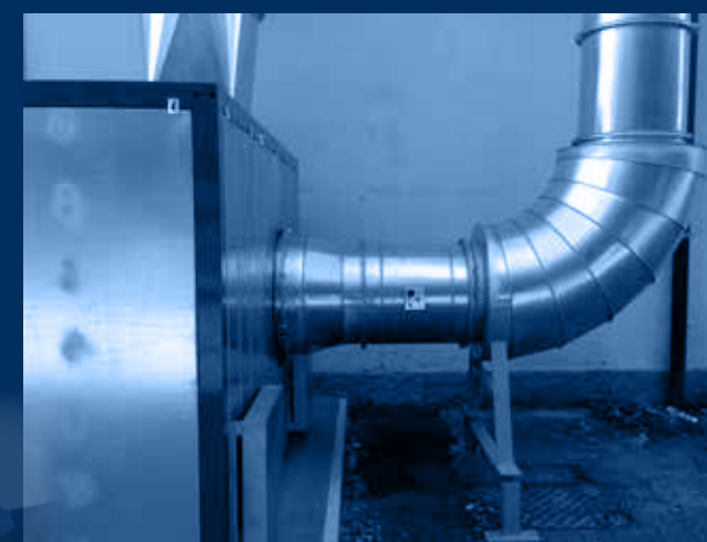
vista silenziatore circolare / circular silencer view
