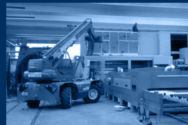
fasi di montaggio UTA deumificazione spinta /assembly stages of UTA pushed dehumidification
