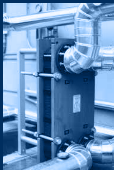
scambiatore h2O/water exchanger
