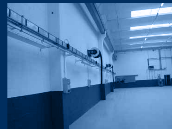
vista serie di arrotolatori per aspirazioni localizzate /hose reels for localized aspiration view
