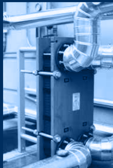
scambiatore h2O/water exchanger
