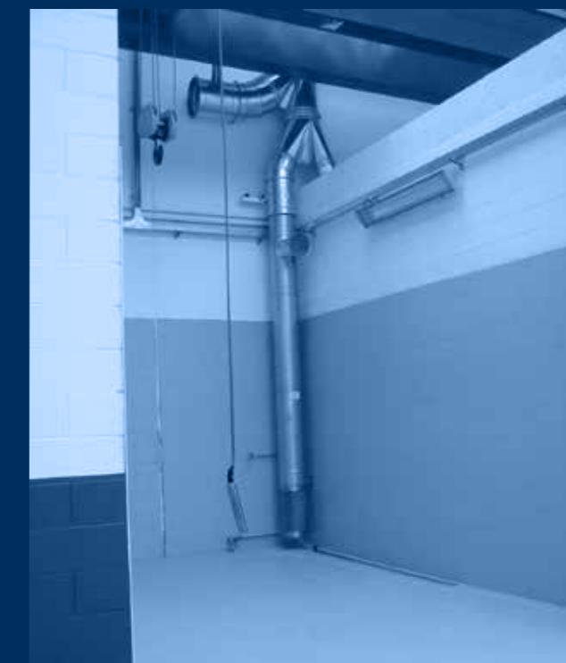
vista distribuzioni interne / internal distributions view
