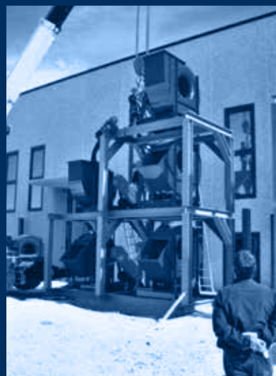
struttura e ventilatori in fase di montaggio / structure and fans assemblage's phase
