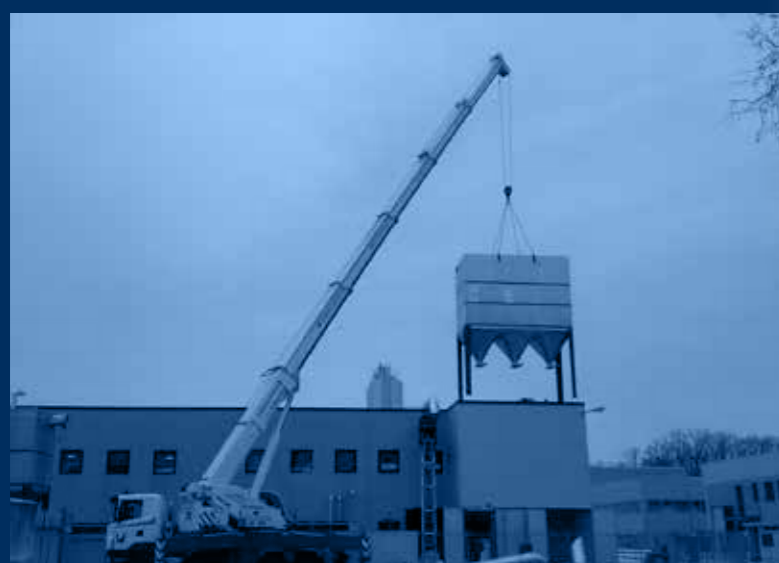
vista globale esterna impianto in fase di realizzo /external global view of the plant under construction
