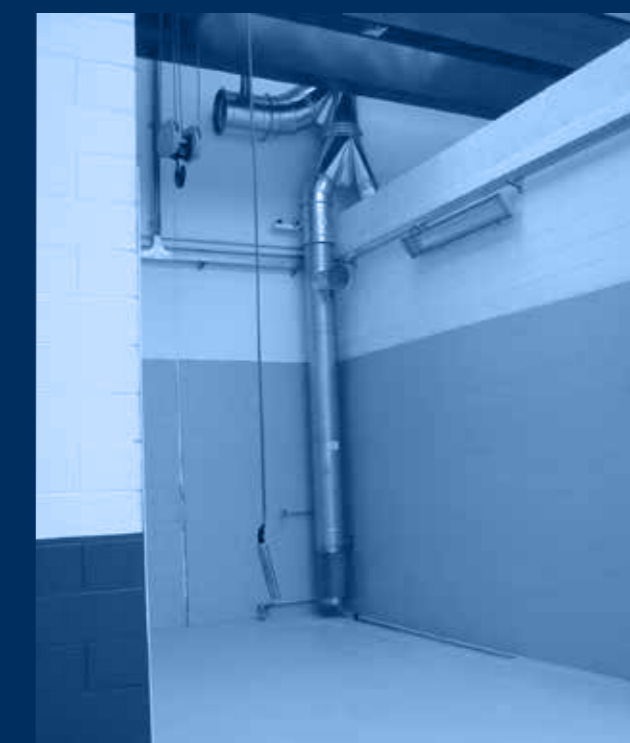
vista distribuzioni interne / internal distributions view
