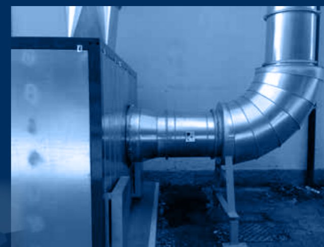
vista silenziatore circolare / circular silencer view
