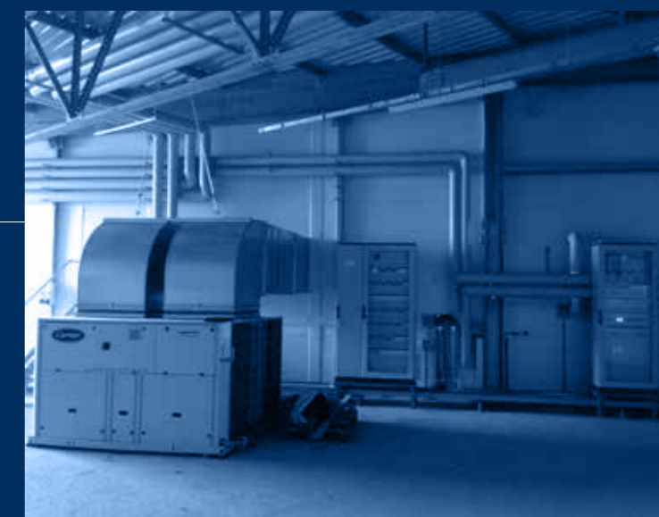
vista refrigeratore scroll canalizzabile condensato ad aria /air cooled scroll chiller view
