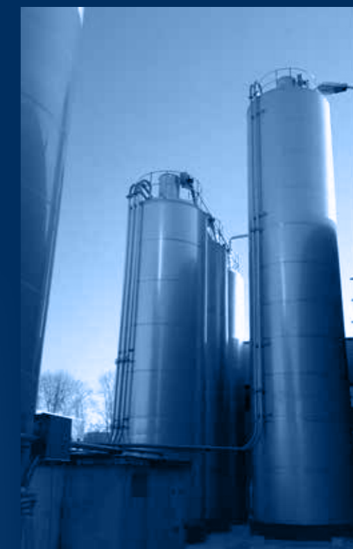
vista impianto esterno in fase di montaggio / external plant in phase of assemblage view
