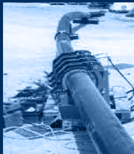
vista posizionamento tubazioni / installation pipes view
