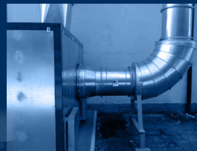
vista silenziatore circolare / circular silencer view
