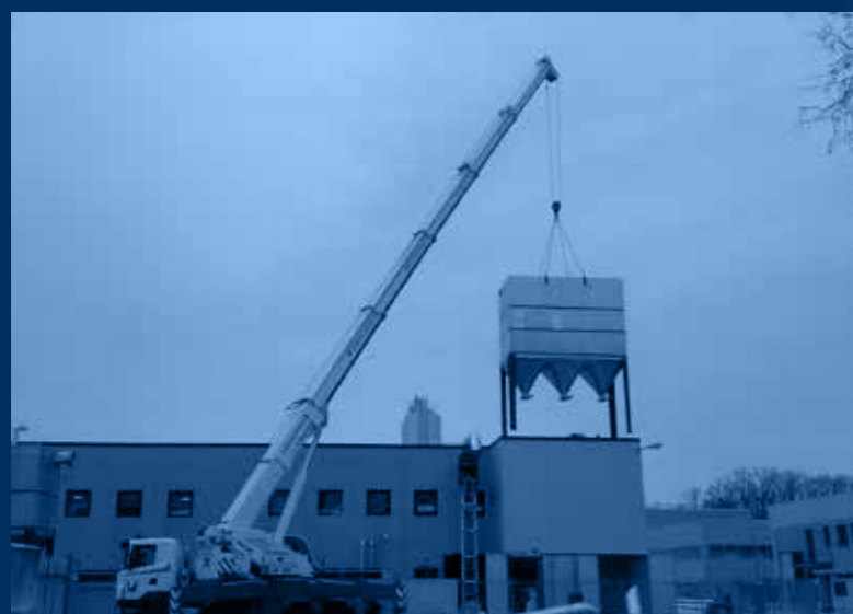
vista globale esterna impianto in fase di realizzo /external global view of the plant under construction
